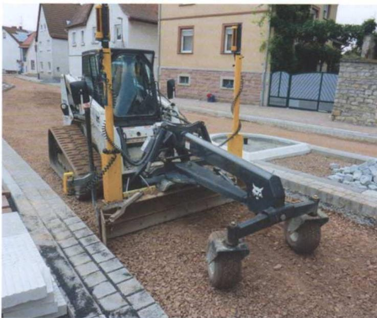
**Automatisch eben:** Auch in verwinkelten Passagen und engen Anschlüssen wird die Frostschuttschicht vom Raupenlader mit Anbaugrader und Automatiksteuerung profilgerecht und schnell eingebaut.
