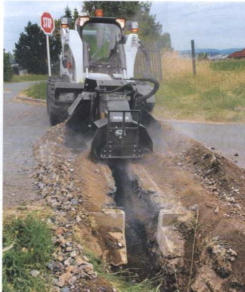
**Neues vom Schlitzer:** Die knapp 1,5 t schwere WS32 ist die bisher größte Radsäge für Kompaktlader. In einem Arbeitsgang wird der Asphalt- oder Betonbelag durchtrennt und der Leitungsgraben bis auf 80 cm Tiefe ausgehoben – auch in gefrorenem Boden.
