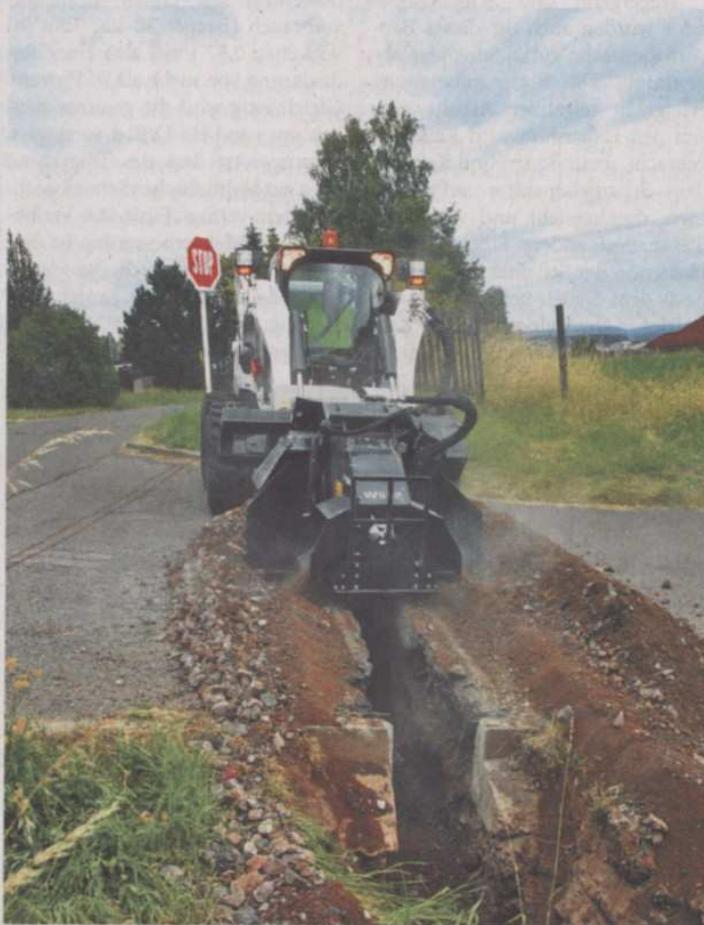
Die neue Bobcat-Radsäge WS32 als Anbaugerät.
