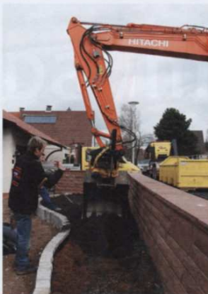
Wird zwischen Ausleger und Werkzeug ein Tiltrotator angeordnet, hier von engcon, übernimmt ein Bagger viele Aufgaben, die zuvor Handarbeit, Schiebkarre und Schaufel erforderten Foto: Kiesel
