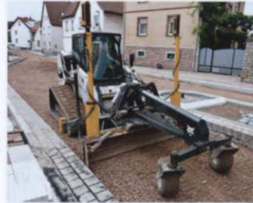
Der Kompaktraupenlader T250 mit dem lasergesteuerten Anbaugrader bereitet das Planum vor.
