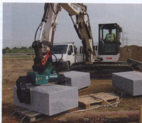
Mit abnehmbaren Gummibacken greift der schwenkbare Steingreif S 1000 von Hunklinger sogar schwere Granitblöcke fest und sicher und baut sie im Handumdrehen präzise ein.
