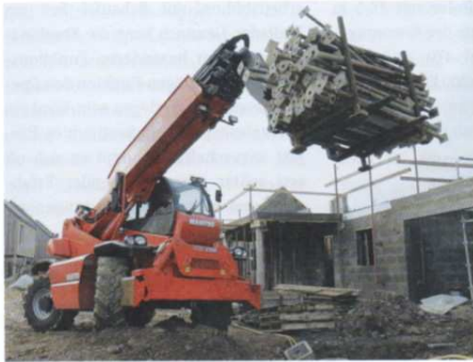
Hoch- und Weitstapler: Drehteleskopen sind vor allem auch vielseitige Geländestapler, die ihre Ladung bei Bedarf auch in Gebäudeöffnungen hineinreichen.
