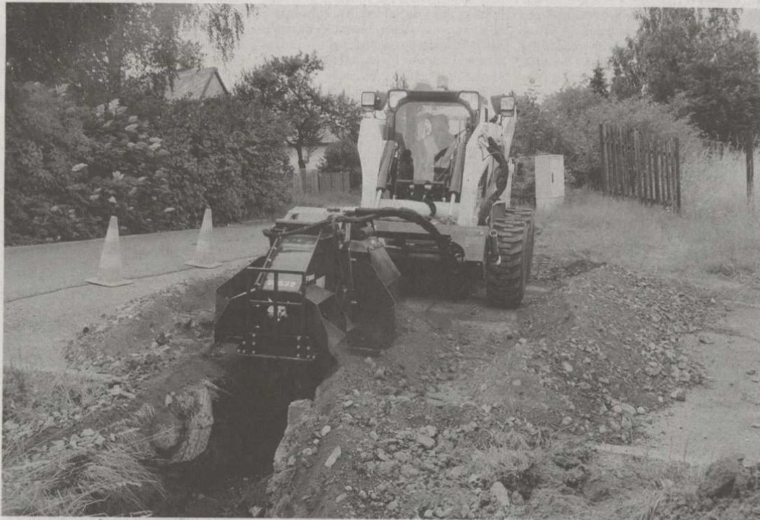
Die WS32 wird stets bei Rückwärtsfahrt betrieben; das Aushubmaterial wird über vier seitliche Öffnungen mit serienmäßig angebrachten Aushubablenkblechen ausgeworfen.
