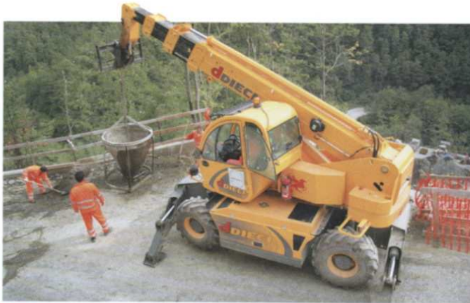
Mühelos: Als wendiger Geländekran mit Allradantrieb und -lenkung bringt dieser Dieci Pegasus den Baustoff per Betonkübel auch an unzugängliche Stellen.
