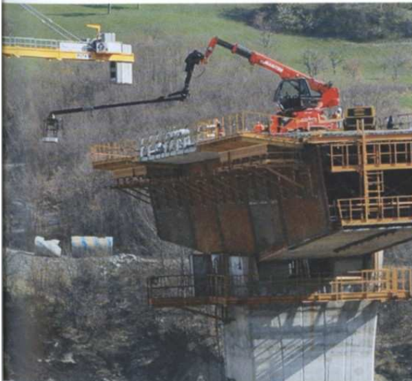
Flugstapler: Drehteleskopen werden per Turm- oder Autokran auch mal an exponierte Einsatzstellen gehoben werden, wie dieser Manitou MRT 1432 mit Personenkorb auf den Pfeiler einer Autobahnbrücke.
