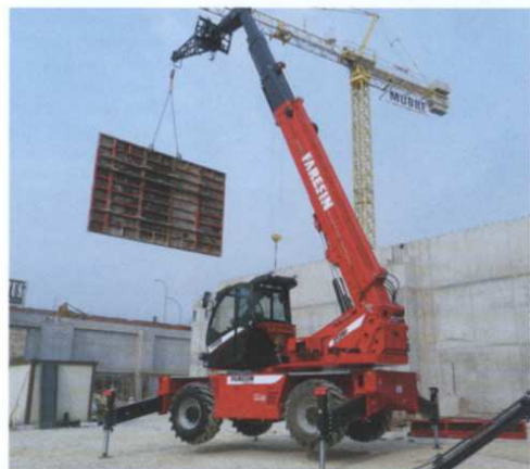
Wettbewerber: Drehteleskopen treten in Konkurrenz zu Turm- und Auto-kränen oder arbeiten als mobile und wendige Geländekrane, wie dieser Faresin Storm 22.45 EVO mit 4,5 t Tragkraft als Einschaler, oder der Manitou TSR 2150 (unten) als Handlanger beim Deichbau mit 18,1 m Reichweite.
