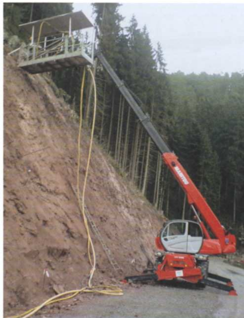
Spritze vom Notarzt: Zur akuten Felsicherung an einer Steilwand wurden mit diesem Manitou MRT 2150 in luftiger Höhe über 700 Felsanker gesetzt. Dazu wurde außer der Arbeitsbühne auch eine 300 kg schwere Bohrlafette montiert.
