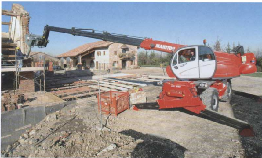
Mischmasch: Vor allem in der Heimat der meisten Teleskopen sind die Mischerschaufeln beliebt – dieser Manitou MRT 2150 liefert frisch gemixten Mauermörtel über den noch offenen Keller direkt an die Arbeitsstelle.
