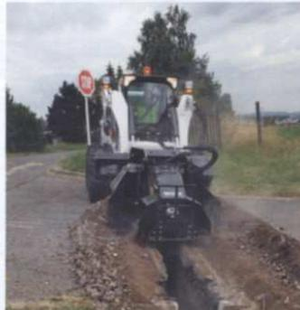
maximale Raddrehzahl beträgt 95 U/min. Anwendungsmöglichkeiten: Grabenaushebung mit fester Breite für Versorgungsleitungen wie etwa Wasser-, Gas-, Stromleitungen, Telekommunikations- und Glasfaserkabelnetze. Die WS32 kann für den Aushebung von Baugruben und für das Fräsen von Schlitzern eingesetzt werden. Sie kann auch für Wartungsarbeiten wie etwa das Graben vertikaler Kanten für Straßen- und Belagsreparaturen genutzt werden.
