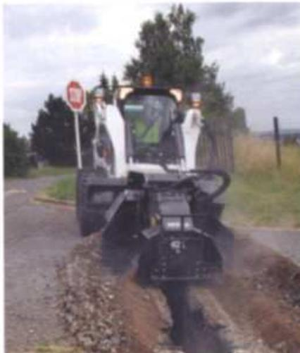
Die WS32 wird bei Rückwärtsfahrt betrieben, dabei wird das Aushubmaterial über vier seitliche Öffnungen ausgeworfen.
